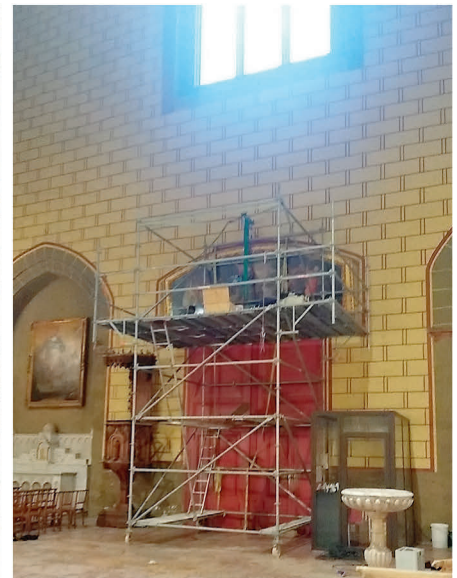
Installation du tableau "Prédication de SAINT JEAN BAPTISTE"
